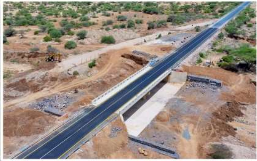
Muonekano wa Daraja la King'ori lililokamilika kujengwa mkoani Arusha kupitia mradi wa ujenzi wa madaraja ya dhanura ya CERC.
